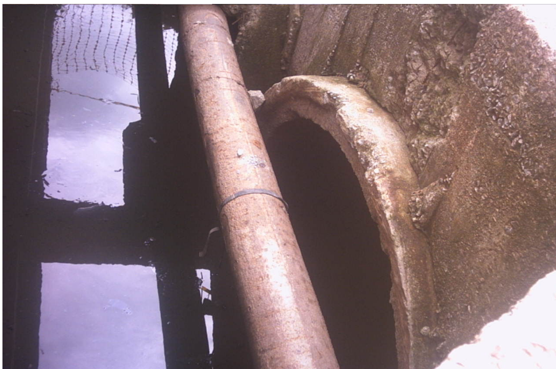
Figura 5: Construção da EET.
