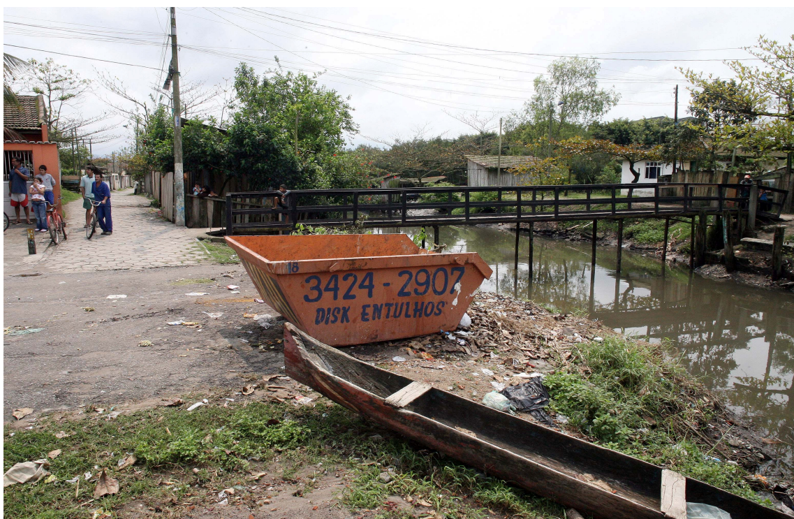
Figura 4: Ponte sobre o Canal do Anhaia.
