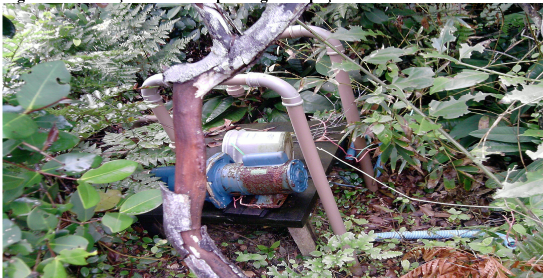
Figura 4- Instalação de bomba para água de poço.
